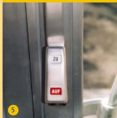
Als Wippe ausgebildeter Panikbeschlag
