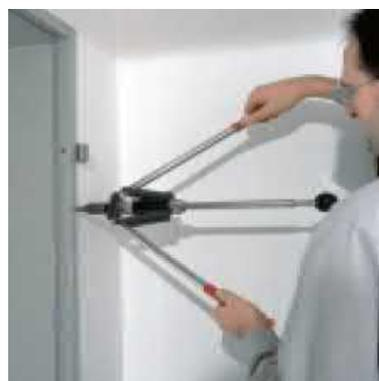
**4.** Mit einer Blindnietzange wird eine Blindeinnietmutter M 10 als zweites Aufnahmeelement in die Bohrung eingebracht. Anschließend werden die Bänder und die Tür montiert.
