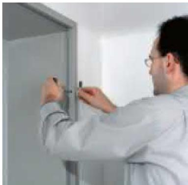
**1.** Durch Lösen der Klemmschrauben werden die alten Rahmentteile aus den Aufnahmeelementen herausgenommen.
