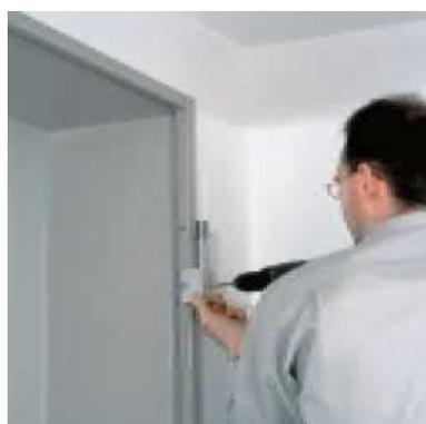
**3.** Die Bohrlehre wird in das obere Rahmenteil eingesteckt. Mit der seitlichen Stellschraube ist sie lotrecht auszurichten, anschließend wird die Bohrung Durchmesser 6,5 mm an der vorhandenen Stahlzarge angebracht und auf 12,1 mm aufgebohrt.
