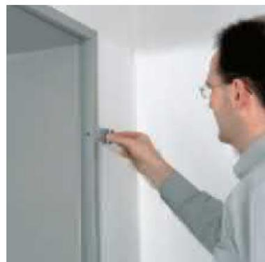
**2.** Das neue Rahmenteil mit Bandlappen wird in das Aufnahmeelement eingesteckt und durch die Klemmschrauben fixiert.
