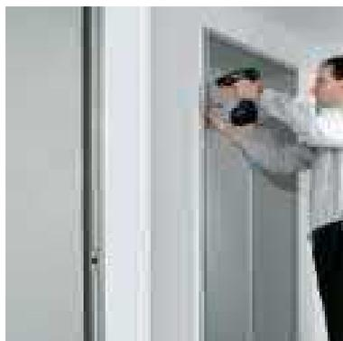
**2.** Mit der Serienbohrlehre VARIANT VN 3700/160, die das Normabstandsmaß von 1435 mm vorgibt, werden 4 Bohrungen 6,5 mm in die Stahlzarge eingebracht. Diese werden anschließend auf Durchmesser 12,1 mm aufgebohrt.
