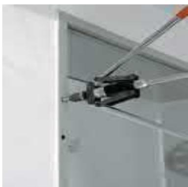
**3.** Mit einer Blindnietzange werden in die Bohrungen Blindnietmuttern M 10 eingebracht. Diese dienen als Aufnahmen für die Bänder an den Stahlzargen. Anschließend werden die Bänder und die Tür montiert.
