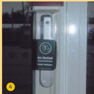
Seitlich drehbarer Panikhebel mit Plastikhaube (um missbräuchliche Benutzung zu reduzieren)
