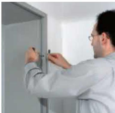
**1.** Entfernen der alten Aufnahmeelemente z.B. durch abflexen, oder abschrauben.
