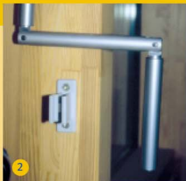
Knickbare Kurbelstange (senkrecht bei Nichtbenutzung)
